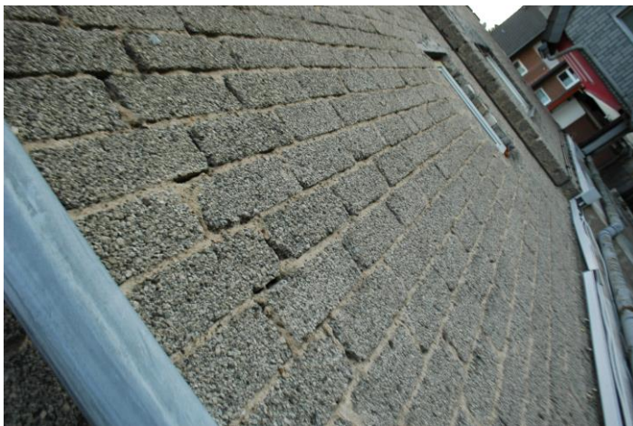
Sanierung fehlerhafter Bauteile
